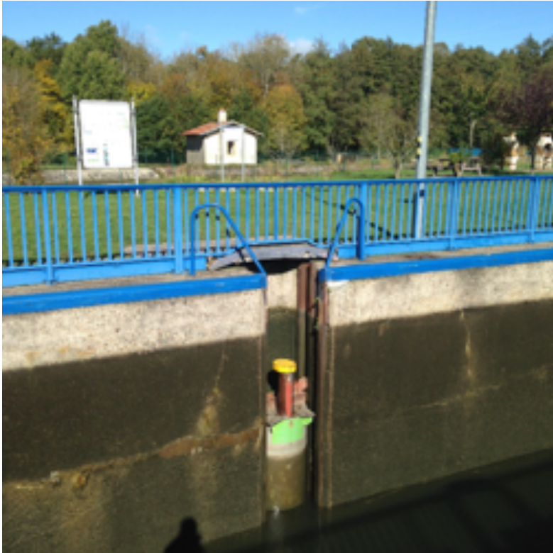
De drijvende bolder beweegt mee met het waterpeil
