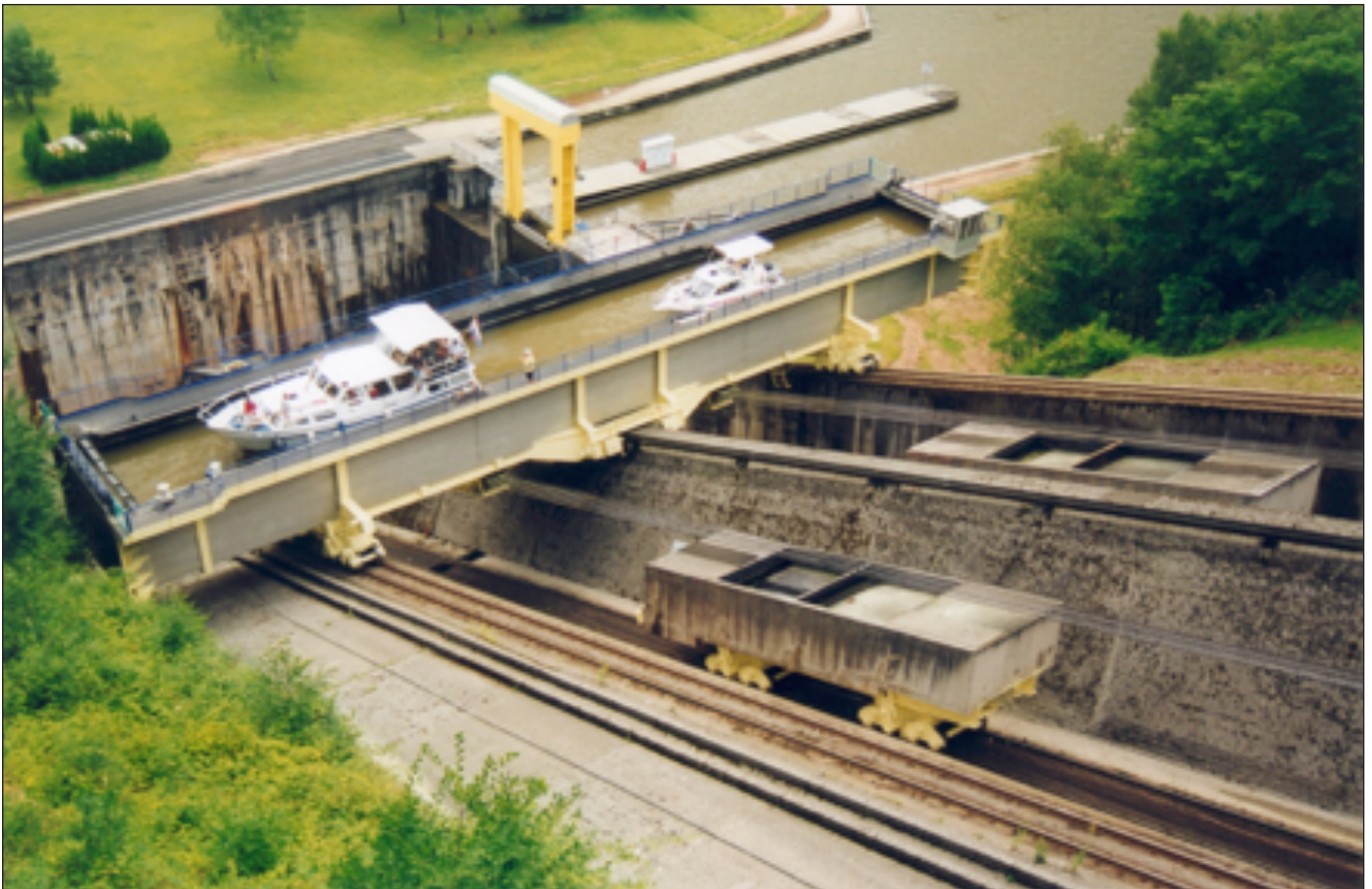
De scheepslift (Plan incliné) bij Arzviller aan het werk met 2 contragewichten van elk 450 ton.
