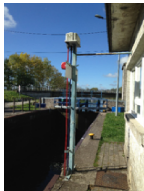
Sluisbediening met stangen
